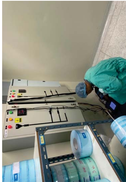
รูปที่ 2 ตัวอย่างการตรวจวัดคุณภาพไฟฟ้าที่ตู้ NEW DB-1
